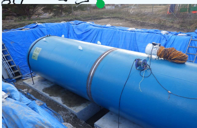
耐震性貯水槽設置工事(東広島市) 積算技術支援、工事監督支援
