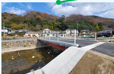
災害復旧工事[沖北川1号橋](呉市) 積算技術支援、工事監督支援
