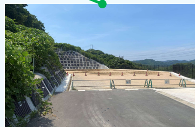
明現配水池築造工事[造成](尾道市) 積算技術支援
