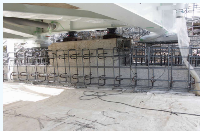
耐震補修工事[土井跨道橋](安芸高田市) 積算技術支援、工事監督支援
