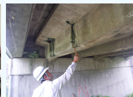
対象橋梁の現地確認
